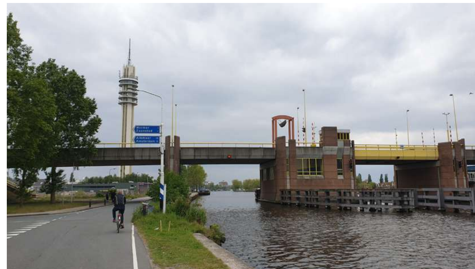
12 de Toren van Wormer fungeert als landmark
