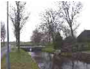
het talud naast de sloot dient onder de dezelfde hoek doorgetrokken te worden tot de zijkant van de dam
