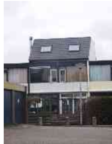
de dakopbouw dient plat afgedekt te zijn en dichte zijwanden te hebben
